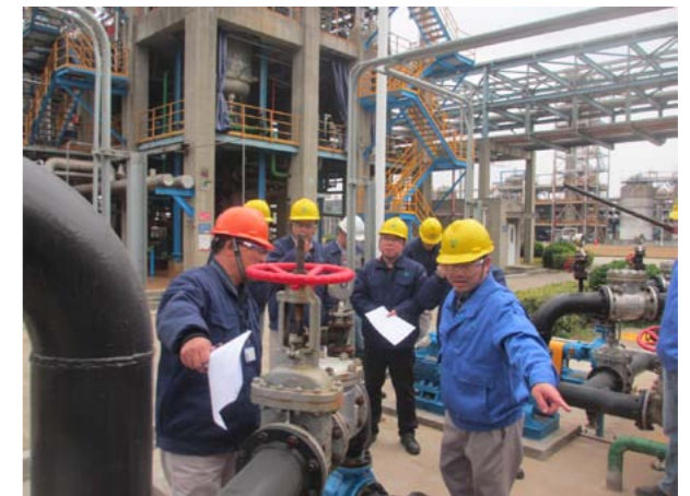
现场安全巡检
