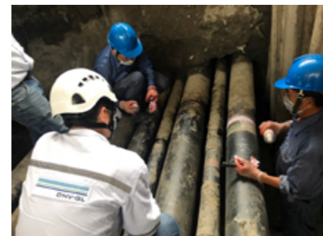
管線開挖驗證查
