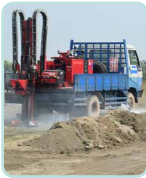
路面施工造成管線洩漏
