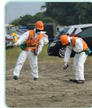
各廠發現管壓異常立即巡視管線
