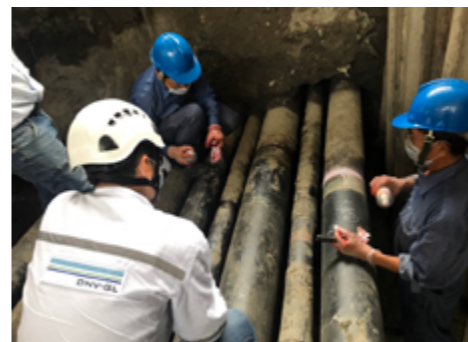
管线开挖验证查
