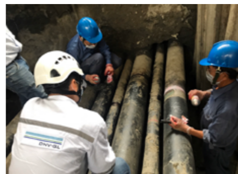
管线开挖验证查
