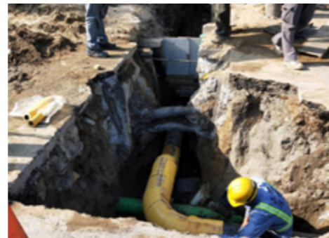
管線開挖驗證檢查
