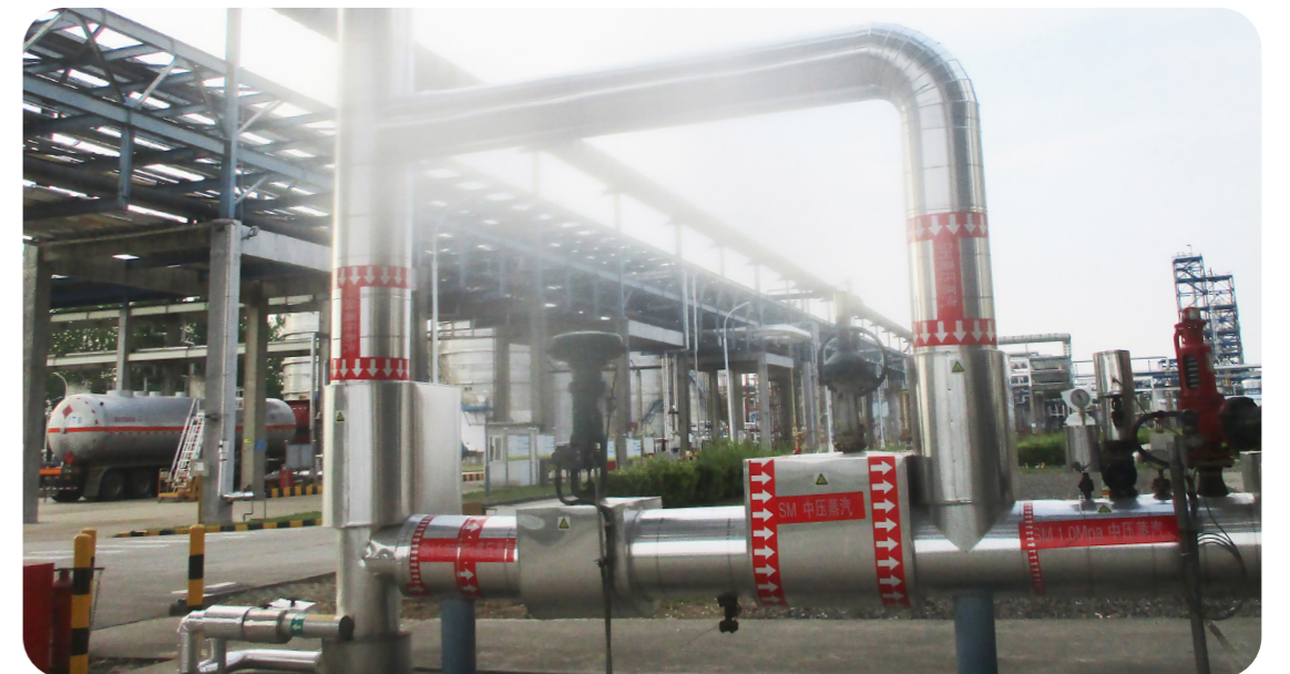
南通實業與台橡宇部 SEBSSIS 蒸汽管汰換
