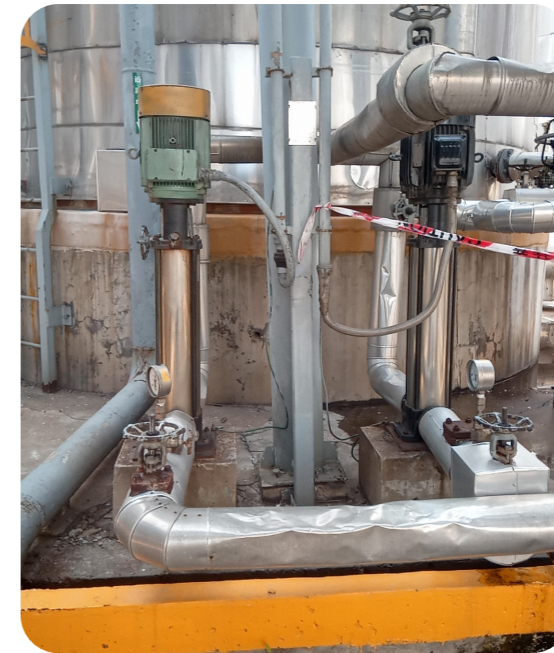
南通實業與台橡宇部 SEBSSIS 蒸汽管汰換
