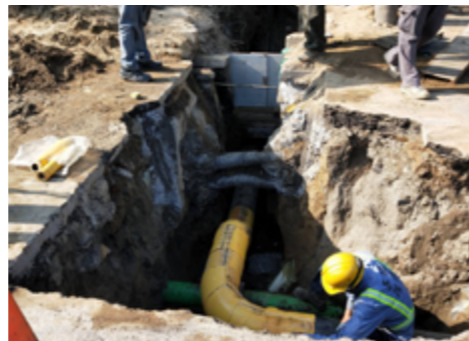
管线开挖验证检查
