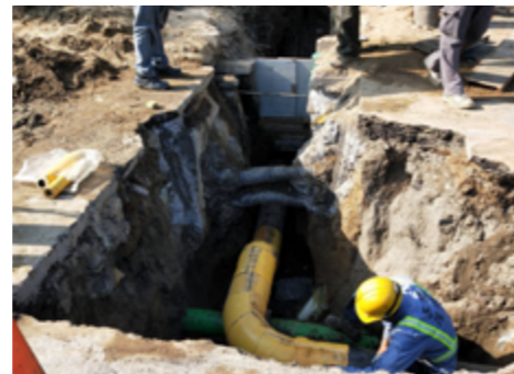
管線開挖驗證檢查
